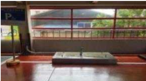
<기초 공사 (실내) 예시>
